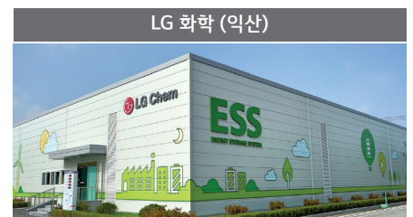
PCS : 3MW / 배터리 : 23MWh 부하 이동용
