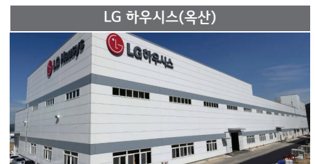
PCS : 500kW / 배터리 : 1.5MWh 부하 이동용
